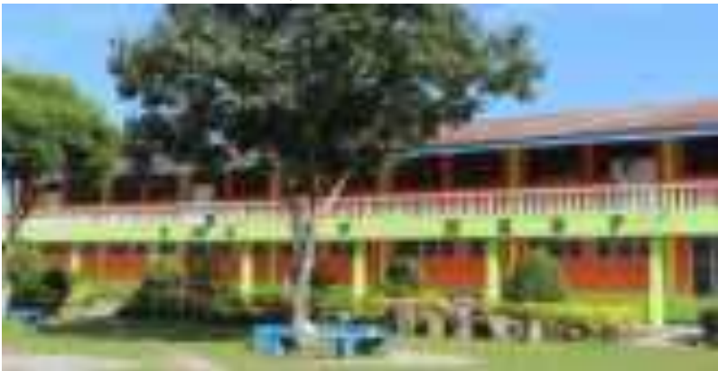
Perguruan HKBP yang terletak di kompleks HKBP Pematangsiantar Jalan Gereja setelah mengalami renovasi. (foto/dok/jal)
