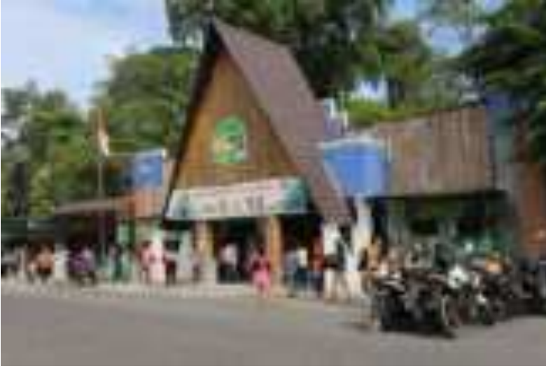
Lokasi depan (gerbang masuk) Taman Hewan Pematangsiantar setelah direnovasi. (foto/dok.jal)
