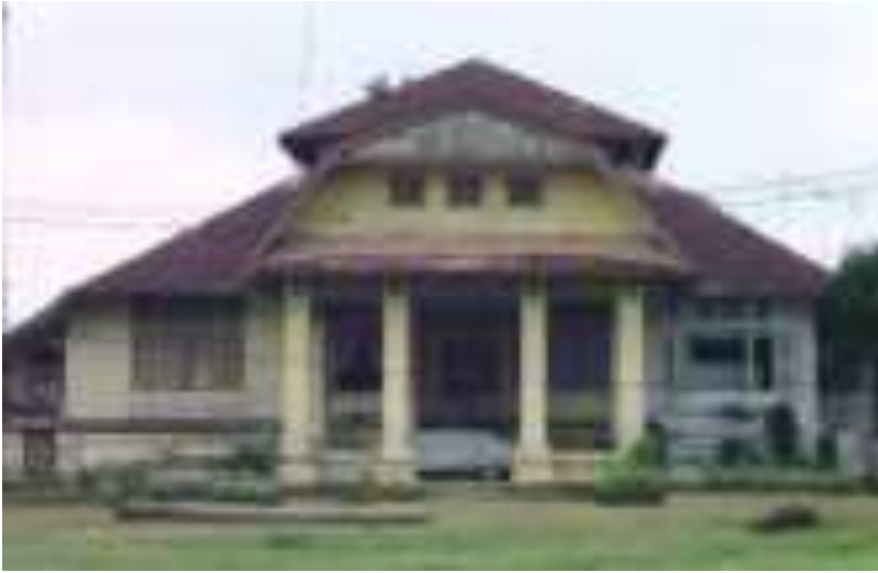
Rumah kediaman dokter yang masih terlihat dengan konstruksi lama di sekitar RSUD Jombang namun kini telah dibiarkan kosong dan kondisinya memprihatinkan. (foto/dok.jal)
