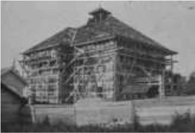
Gedung De Javasche Bank saat dibangun tahun 1923. (foto: kitlv.nl)
