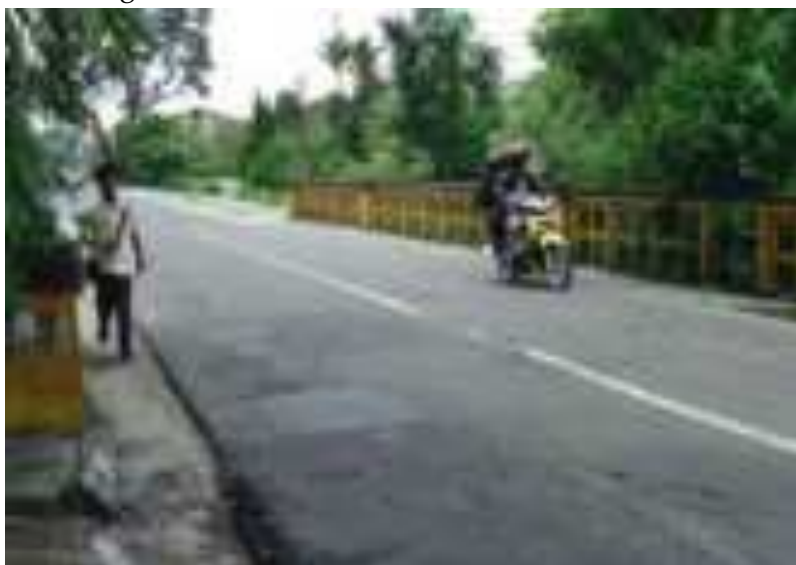
Jembatan yang menghubungkan Jalan Sudirman sebelum direnovasi (atas)
