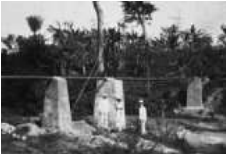
Pembangunan pipa air minum di Pematangsiantar tahun 1922 (foto:kitlv.nl)
