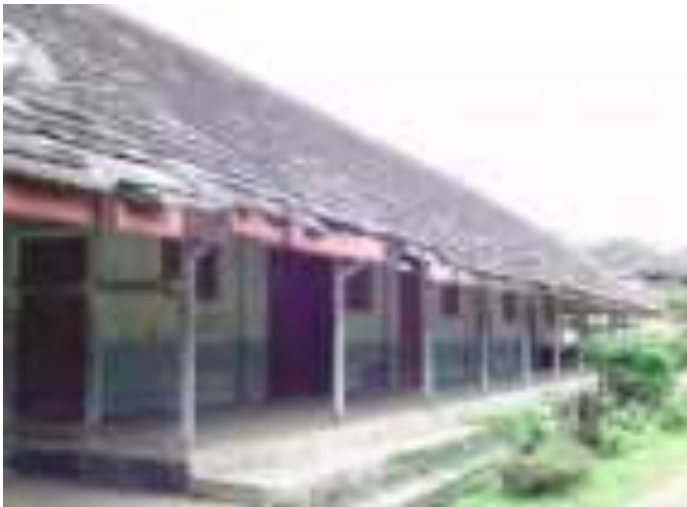
Bangunan lama ruang kelas SMA Negeri 4 sebelum direnovasi (foto/dok.jal)
