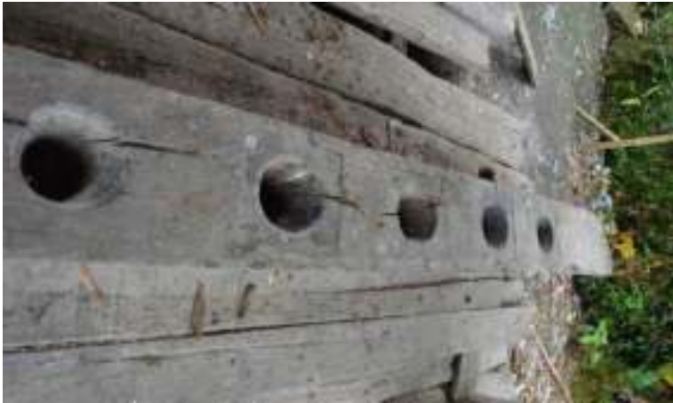
Gambar 5. 22 : Losung yang terdapat di atas (Sumber: Dok. TACB Kab. Simalungun)
