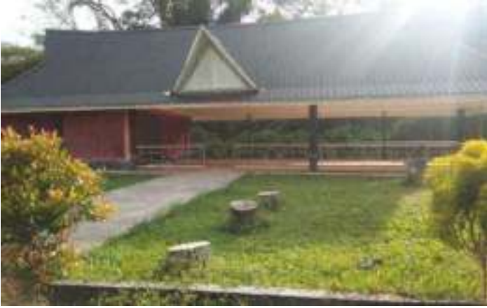
Gambar 5. 42: Kondisi bangunan baru di Komplek Rumah Bolon Pematang Purba Kabupaten Simalungun. (Sumber: dok. TACB Kab. Simalungun).
